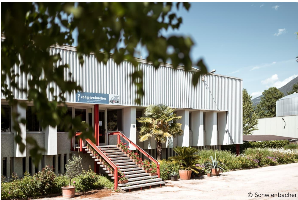
Das Firmengebäude der Firma Schwienbacher in Lana
